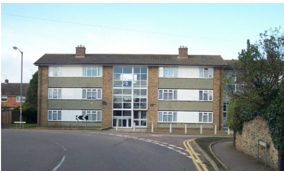
Roman Gate flats
